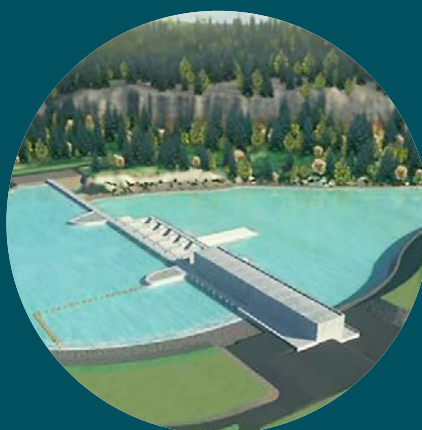
Central hidroeléctrica Rucalhue
